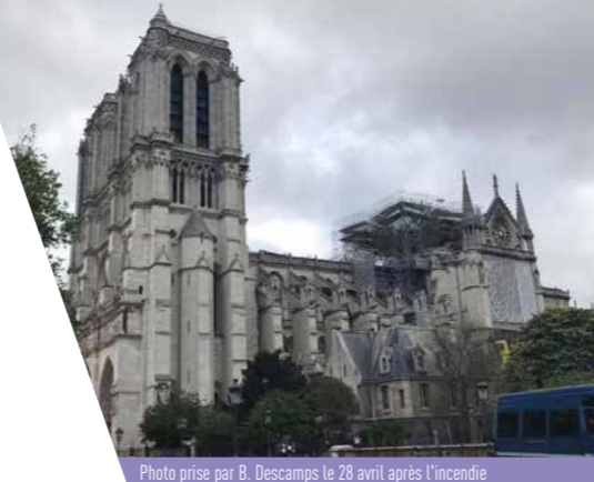
Photo prise par B. Descamps le 28 avril après l'incendie
